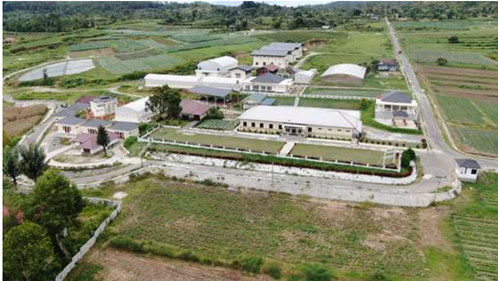
Gambar 3.10. Gedung Perkantoran dan lahan produksi di IP2TP Gurgur
