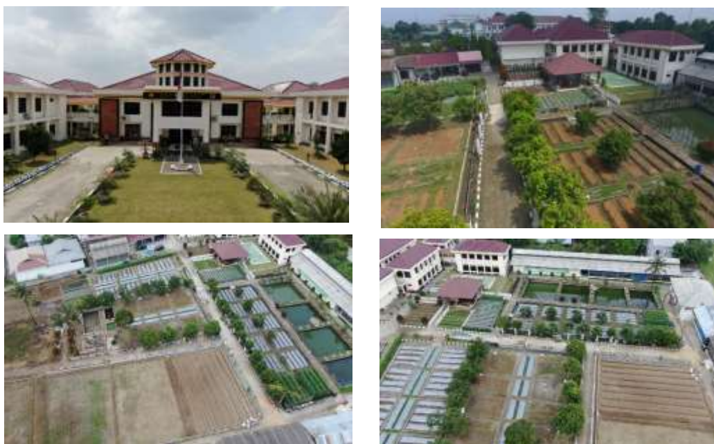
Gambar 3.5. Gedung Perkantoran, Mess dan Rumah dinas BPSIP Sumut
